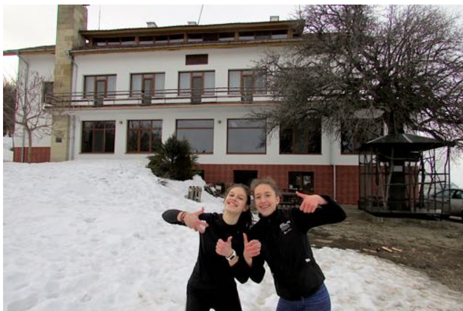
Trotz «Dachschaden»: Insgesamt ist das Berghaus «Mladost» ganz okay. Die Fassade wurde eben erst saniert, die Heizung erneuert, die Zimmer renoviert.
